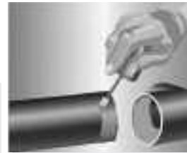
APPLICATION du polymère de soudure
